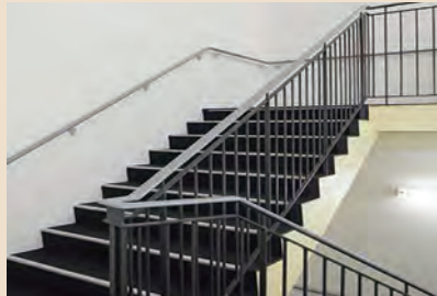
階段手すり・ノンスリップ
