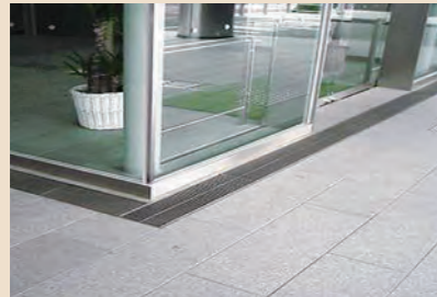
排水グレーチング
