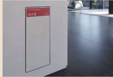
消火器ボックス
