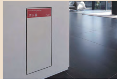
消火器ボックス
