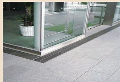
排水グレーチング
